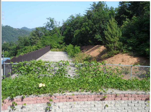
상부 성토부 전경
